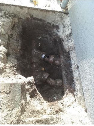
Foto van de huidige staat van de gresriolering.
